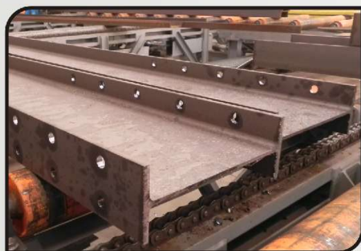
Sistema automático para furação e corte de vigas soldadas
