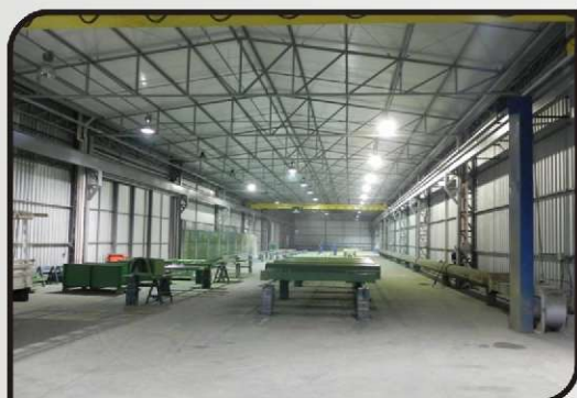
Cabines de pintura com controle de ambiente
