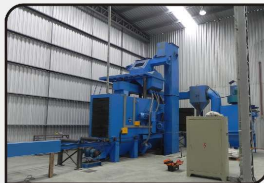
Sistema automatizado de jateamento de granalha de aço
