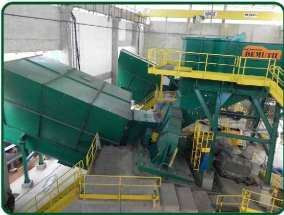
Chipper Building / Prédio dos Picadores
