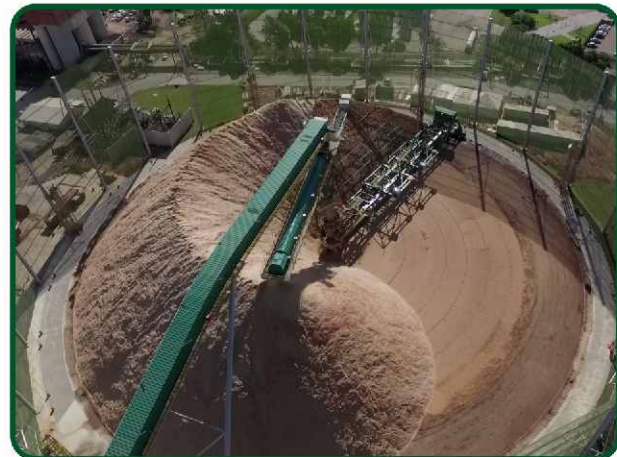
130.000 m³ | Stacker Reclaimer
